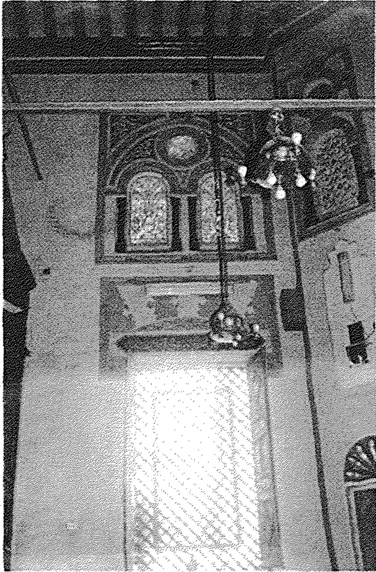
لوحة رقم ( ٢٢٨ ) : طراز شبابيك مسجد الحبشى من الداخل - بدمنهور الشبابيك المستطيلة تعلوها نوافذ قندلون مغطاة بالزخارف النباتية والهندسية بالزجاج الملون المعشق فى الجص
